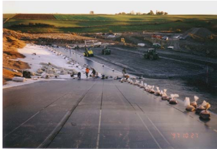
Abbildung 4: Eine eingebaute Kunststoffdichtungsbahn mit vollständiger Glattlage (Quelle: R. Schicketanz).
